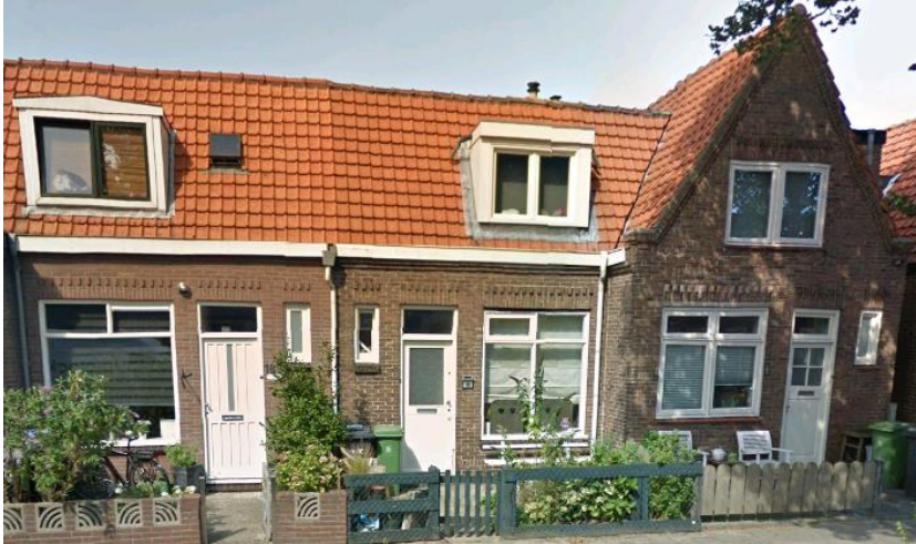
figuur 5 Voorbeeld grondgebonden ongeschikt
